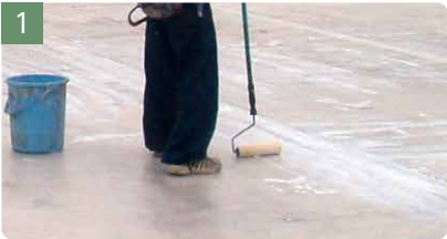
プライマー塗布
